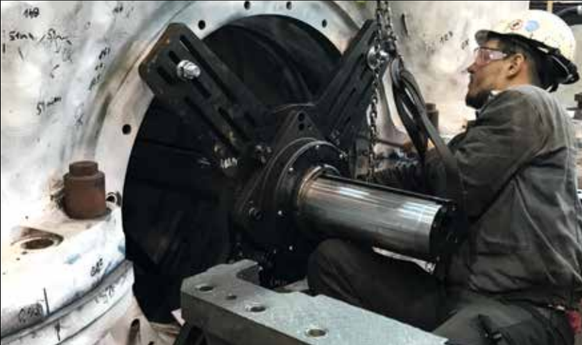
▲ Rohrschneider und Schweißvorbereitung.
