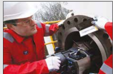
▲ Flanscbearbeitungsmaschinen, um zuverlässige Flanschverbindungen zu gewährleisten.
