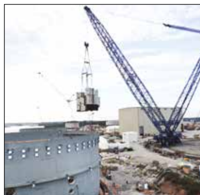
▼ Verankerungsspezialisten setzen das SyncHoist-System ein, um bei der Positionierung eines 1140 t schweren Moduls eines Kernkraftwerks jeden Hubpunkt separat oder zusammen synchronisiert präzise einzustellen und zu überwachen.
